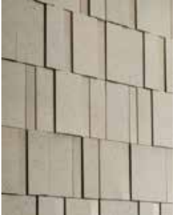
■1階メインエントランスサイドタイル TPR-300+SAN-16
